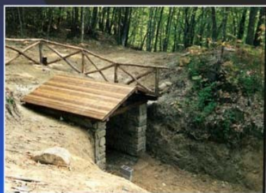
Particolare della struttura ormai in fase di ultimazione: manca la copertura in piagne
